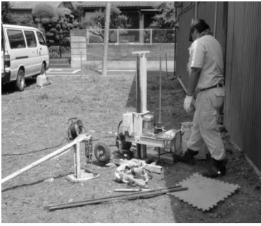
地盤調査中 撮影
