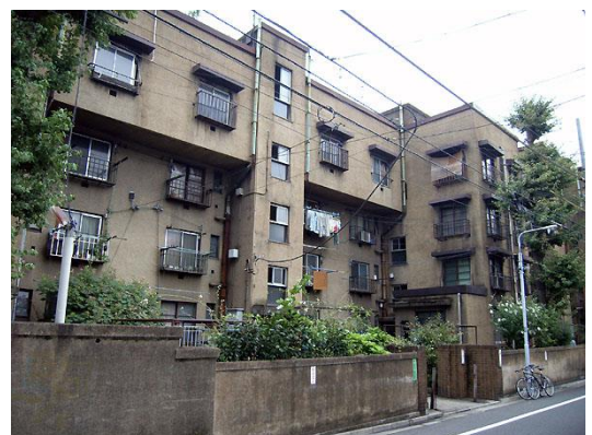
5月に解体される最後の同潤会「上野下アパート」
