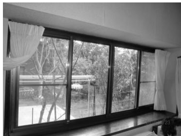
断熱窓に交換
