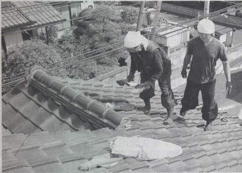
軽量瓦に交換し、柱の負担を減らす改修工事(さいたま市内で)
